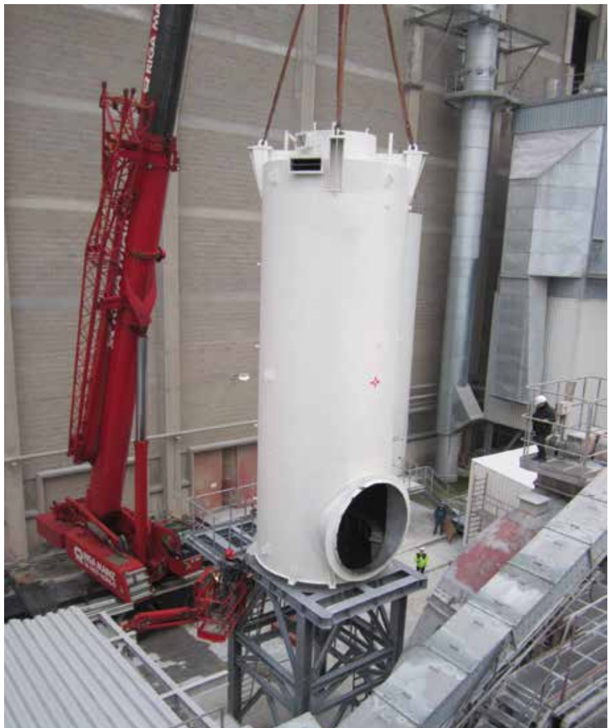
1. MONTAGGIO DELLA CAMERA DI COMBUSTIONE ASSEMBLING THE COMBUSTION CHAMBER
